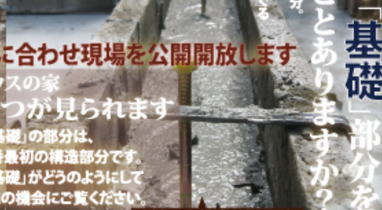
写真:基礎コンクリート打ちと土台を覆えるアンカーボルト
