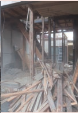
内部解体後写真
