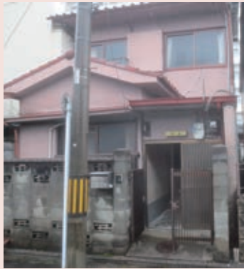
内部解体前写真
