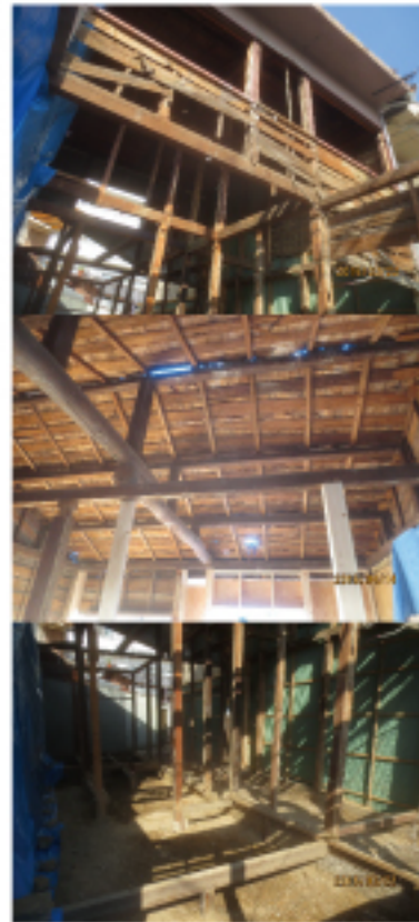
内部解体直後の様子 (3月下旬撮影)
