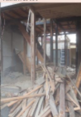
内部解体後写真
