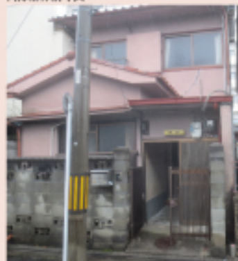
内部解体前写真
