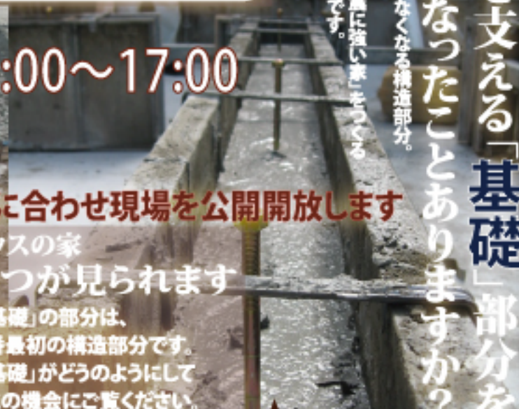
写真：基礎コンクリート打ちと土台を覆えるアンカーボルト
