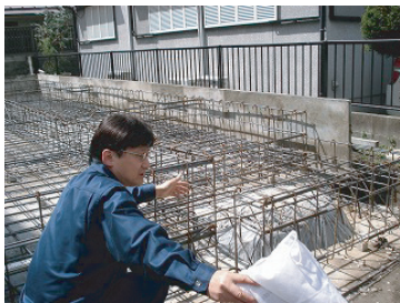
弊社住宅のベタ基礎の形状(断面)
